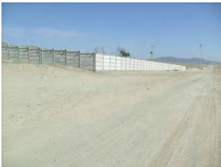
Fotografía 13: Punto Monitoreo MA 12. Sustrato de camino corresponde a depósitos eólicos inactivos (Edad Cuaternario)
