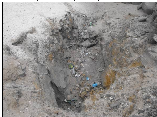
Polvorín expuesto del fuerte
