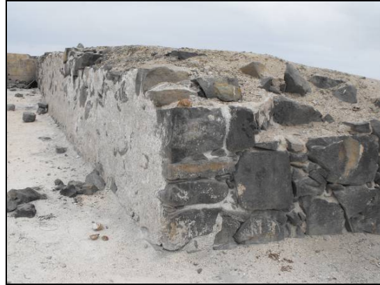
Muro expuesto de piedra y conchilla
