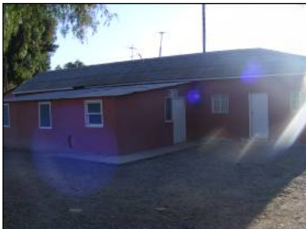
Fotografía 5.10-36: Vista Posta Rural, San Pedro
