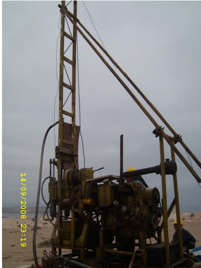
Foto N°3.1: Instalación de maquina de sondaje
