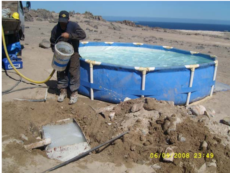
Foto N°3.2: Instalación de piscina y pozo para lodo
