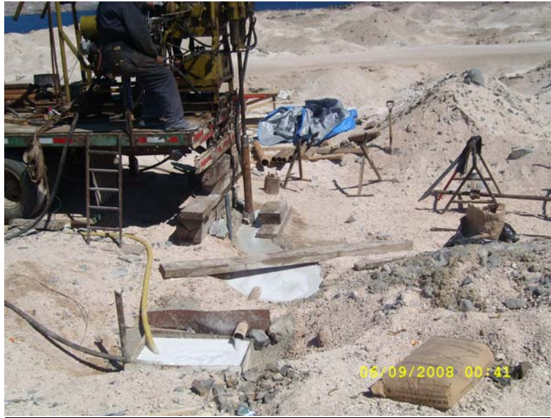
Fotografía 11: Detalle de perforación en ST4
