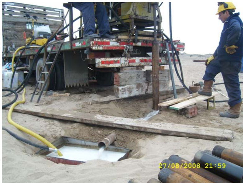
Fotografía 2: Detalle de perforación
