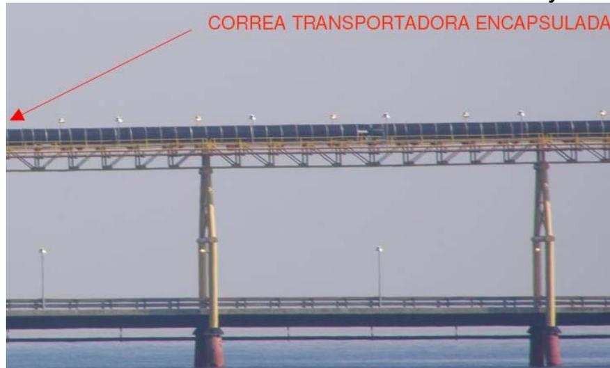
**Fotografía 1:** Ejemplo de Correa Transportadora de Mineral Encapsulada, se recuerda que se realizará además un doble confinamiento hermético (ver Fotografía 3 de la presente Adenda)
