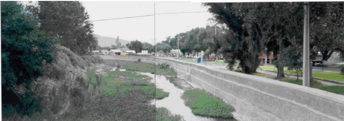
Figura N°4.2 Estación en Ciudad de Copiapó. Enero 2001.
