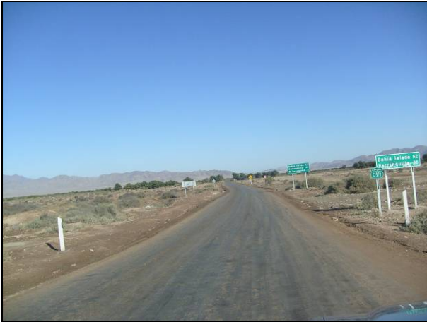
Fotografía 5.13-19: Vista de área de trazado acueducto, punto AC 7
