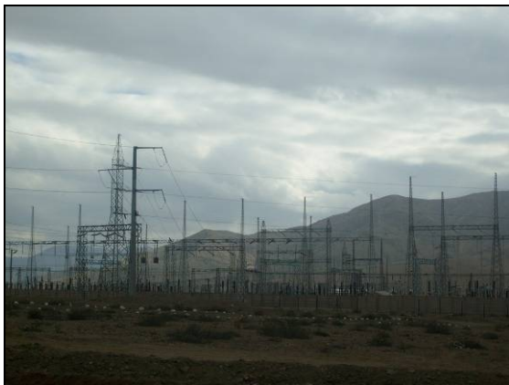
Fotografía 5.13-11: Vista de punto LE 1, inicio de trazado eléctrico al suroeste de Cuesta Cardones
