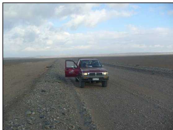
Fotografía 5.13-16: Vista de punto LE 15, hacia el Sureste
