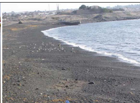
Fotografía 5.9-6: Punto 5: playa escorial. Muelle abandonado ex terminal de Hierro
