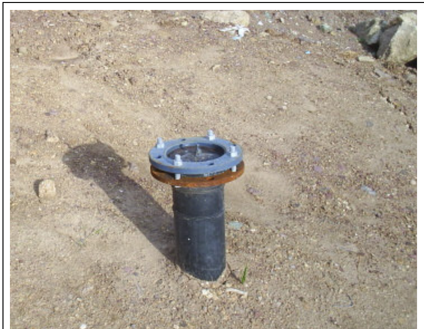
ACONDICIONAMIENTO DE POZOS
