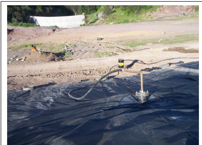
SELLADO DRENES VERTICALES
