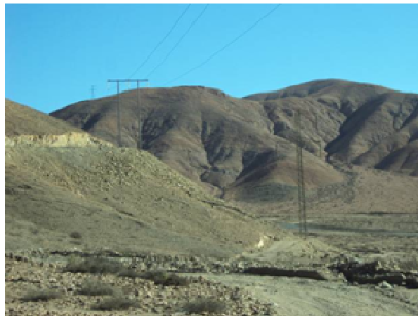
Líneas eléctricas y caminos para su mantención
