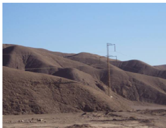
Se observa línea eléctrica.
