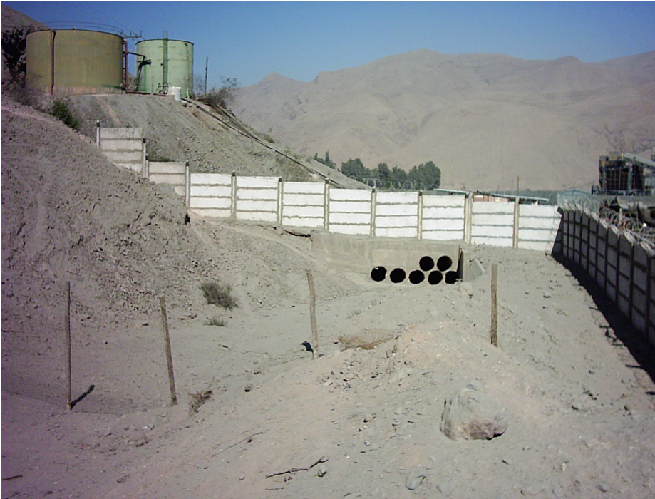
Fig. 4.40a: Canal de drenaje natural en el extremo sureste del sector de la planta. Se puede observar la canalización mediante tubos, que permite que eventuales flujos puedan cruzar este sector de la planta siguiendo su dirección natural sin alteraciones.
