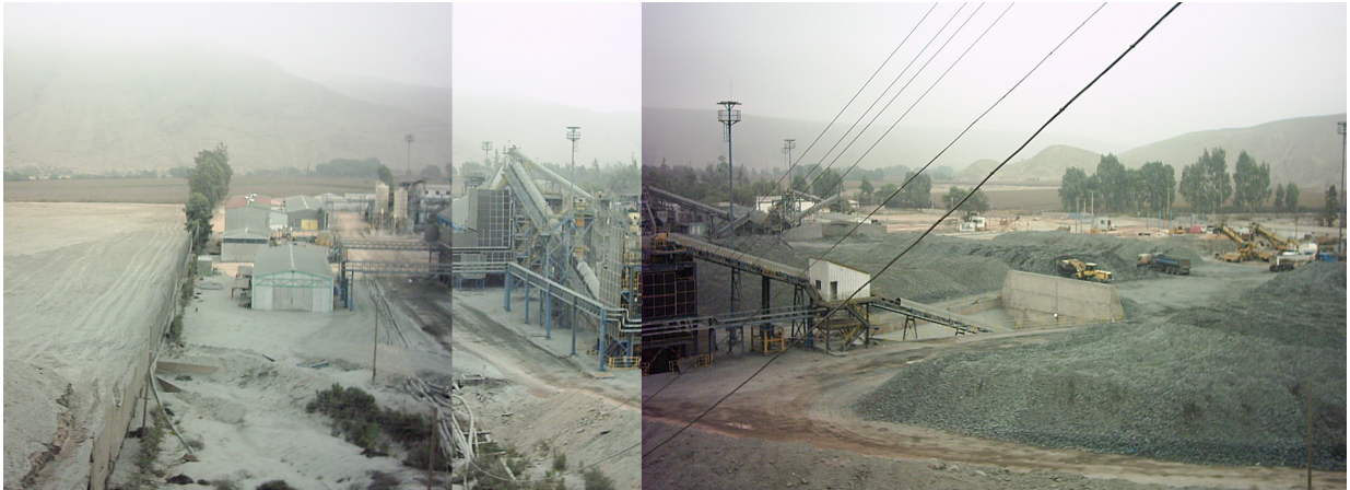
Fig. 4.22: Vista de la planta desde el sureste.
