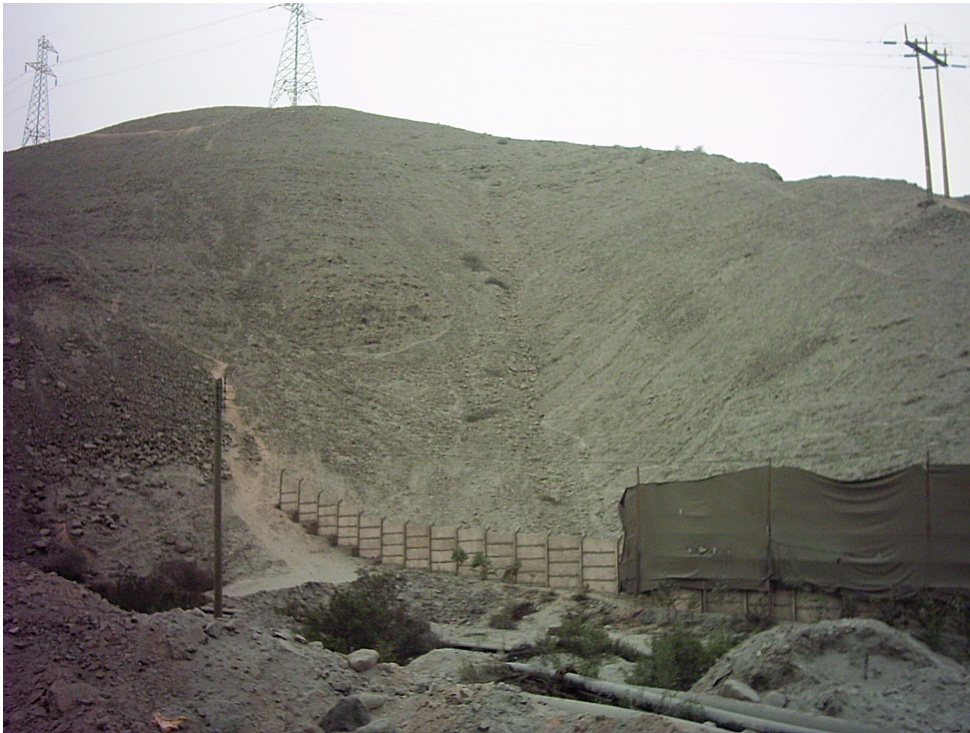
Fig. 4.36: Quebrada lateral al este del sector de la planta. Al costado del cierre se ubica el canal de drenaje natural mencionado en el texto.
