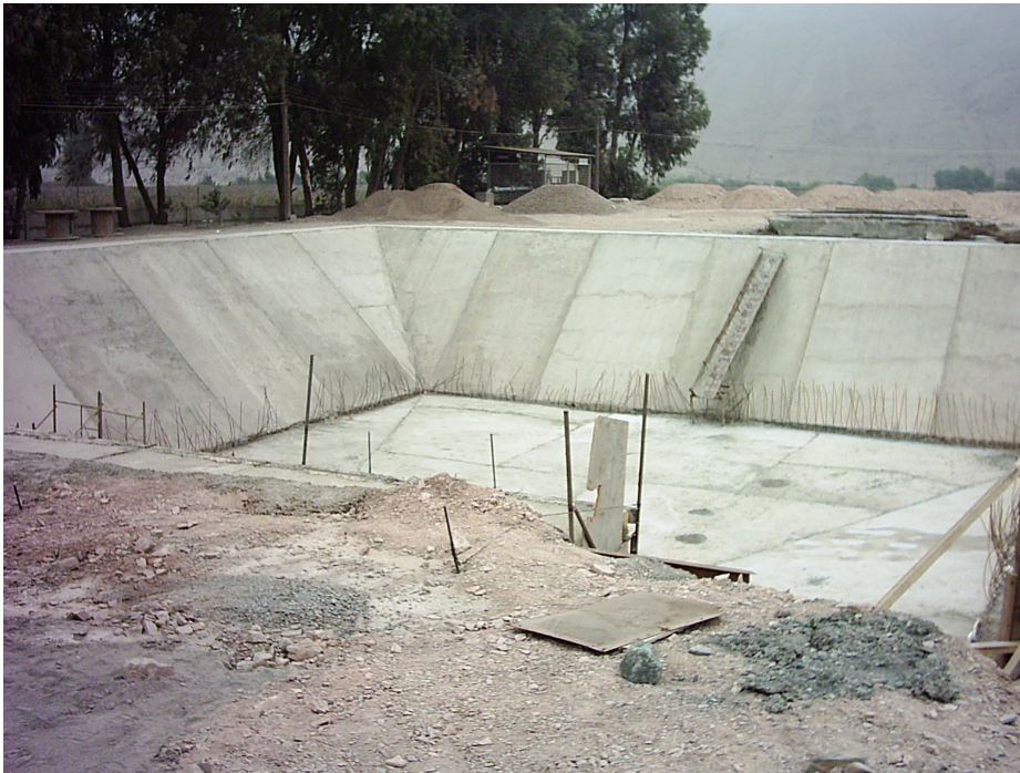
Fig. 4.32: Piscina de captación en proceso de construcción.
