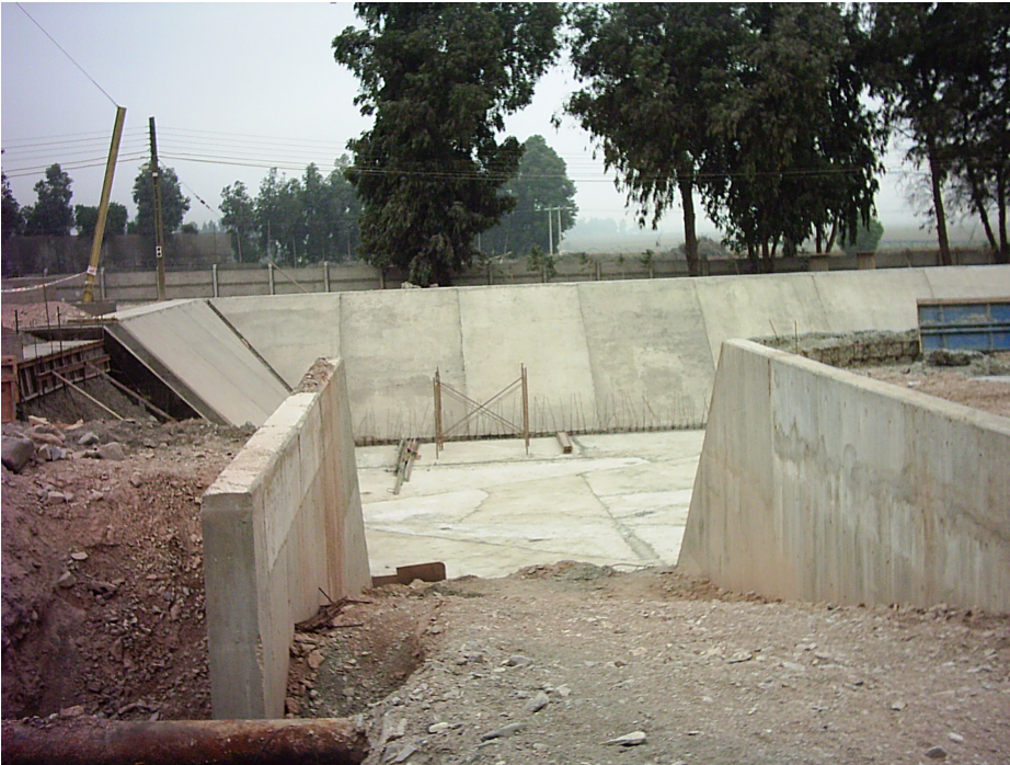
Fig. 4.31: Piscina de captación en proceso de construcción.
