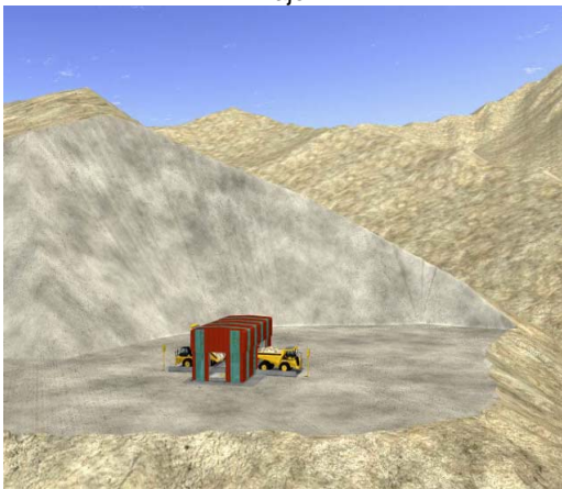
Chancador primario, observándose tolva de recepción
