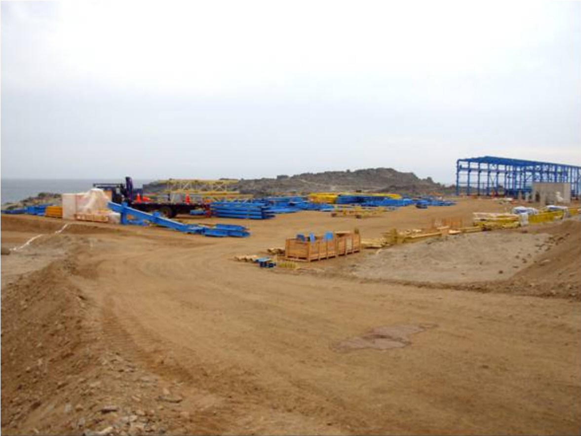
Ubicación Planta donde se encontraba preparada la plataforma para la subestación eléctrica
