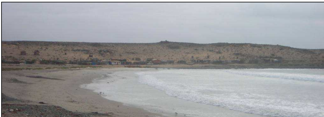
Fotografía 5.5.2-2 Viviendas en Caleta Pajonales.
